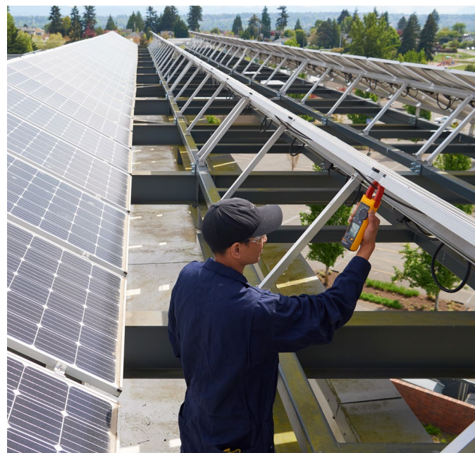
Řešení problémů je jedna z nezbytných dovedností profesionálního technika solárních systémů. Zde technik odečítá hodnoty na zadní straně fotovoltaického panelu pomocí přístroje Fluke 393 FC.
