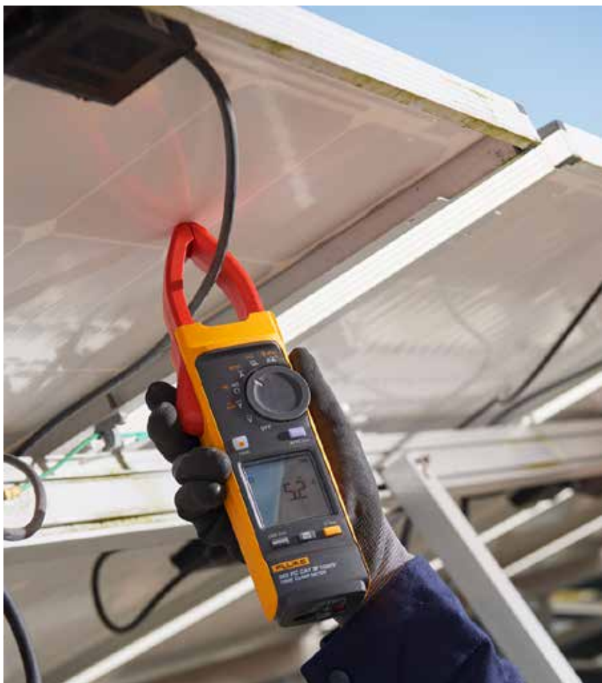
Měření proudu na fotovoltaickém panelu pomocí klešového přístroje Fluke 393 FC.
