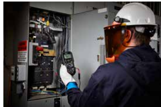
Volitelná flexibilní proudová sonda TA7x umožňuje měřit proud o velikosti až 3 000 A AC.
